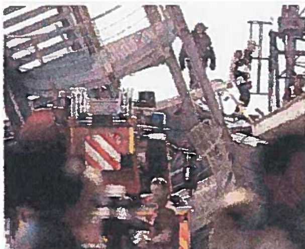
Per il crollo della Torre Piloti le vittime furono nove
